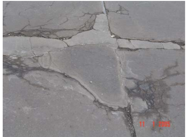
Bild 7 Kantenabbrüche mit „Ausbesserungen“
