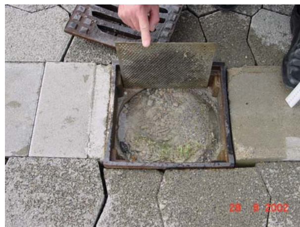
Bild 3 durch Betonbettung zugesinterter Einlauf
