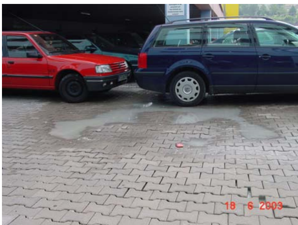
Bild 2 Pfützenbildung durch unzureichendes Gefälle
