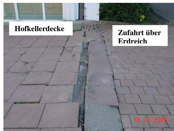
Bild 4 Plattenbeläge 40 cm x 40 cm x 8 cm auf einer Hofkellerdecke für LKW-Verkehr
