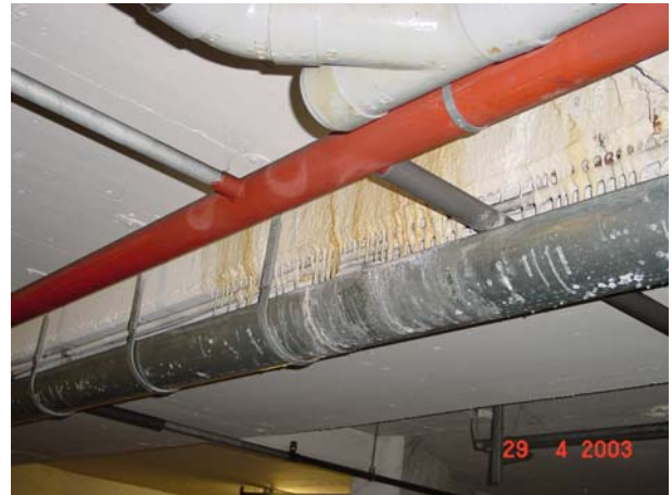
Bild 18 untergehängte Rinne in einer Tiefgarage
