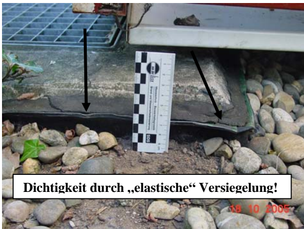
Bild 5 Abdichtungsanschluss der Folienabdichtung an einen Lüftungsschacht
